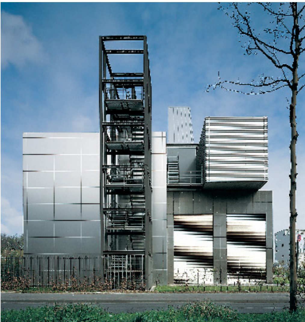
Die unterschiedlichen Fassadenbekleidungen des Stahlbetonbaus machen einzelne Funktionsbereiche ablesbar.
