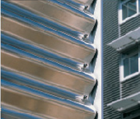
Die Edelstahl-Wellbleche sind in gleichmäßigen Abständen sichtbar befestigt.
